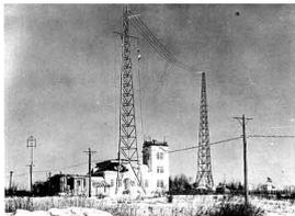
Позднее, с 10 года Тайсё (1921 год) по 5 год Сёва (1930 год), четыре раза проводились работы по строительству дизельной, комнаты для сейсмологических наблюдений и ряда других помещений. Трёхэтажная пристройка из железобетона к основному строению внесла в него существенные изменения.
